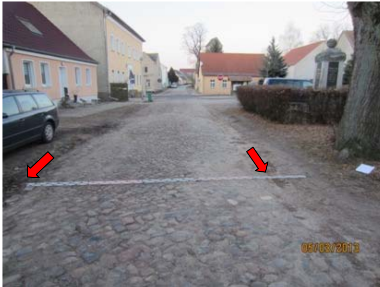
Abb. 6 Fahrbahnbreite am Baum 1 (rechts) 4,30 m, Zum Vergleich 5 m Nivellierlat- te
