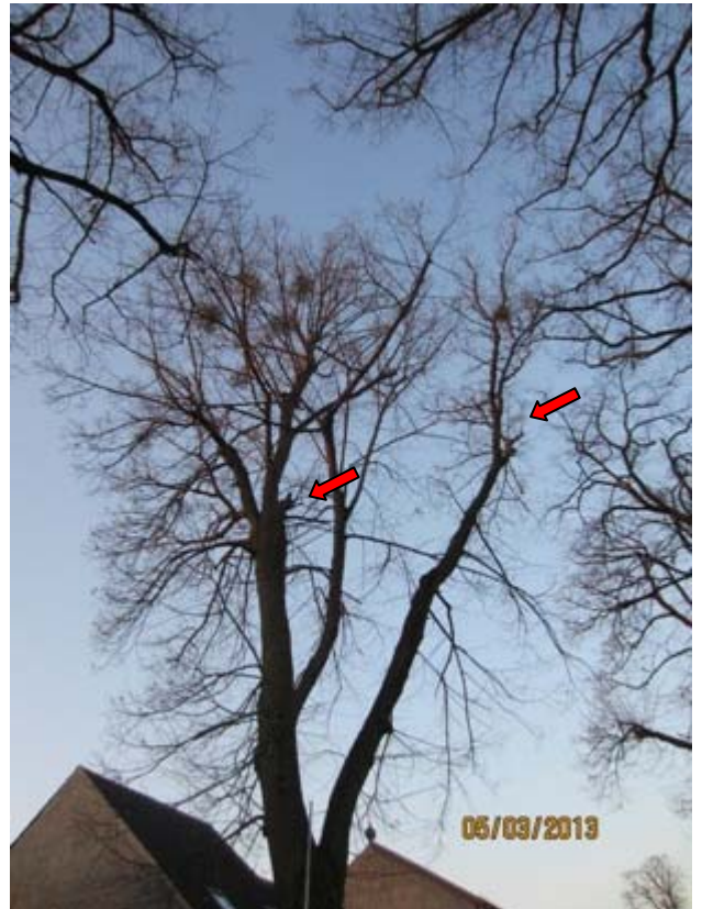
Abb. 89-Linde 27- Kronenansicht, mehrere Bruchstellen
