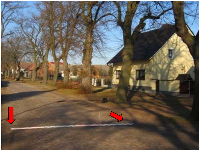
Abb. 7 Fahrbahnbreite am Baum 15 (rechts) 4,00 m, Zum Vergleich Nivellierlatte 4 m lang ausgezogen
