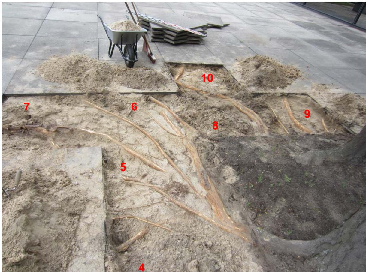
Abb. 109 Gleditschiengruppe 7-8, Wurzeln freigelegt, rote Zahlen=Plattenummer, zahlreiche oberflächennahe Wurzeln außerhalb der Baumscheibe
